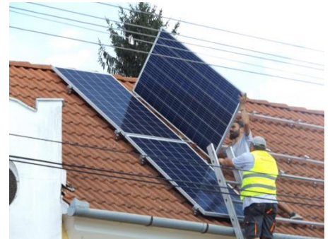
Napelemek telepítése a Nyugdíjas házon
